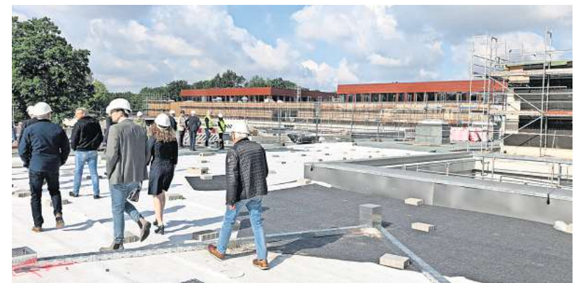
Auslauffläche: Der zukünftige Schulhof des Gymnasiums befindet sich auf dem Dach.
